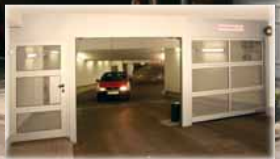
Ein- und Ausfahrt des Parkdecks
