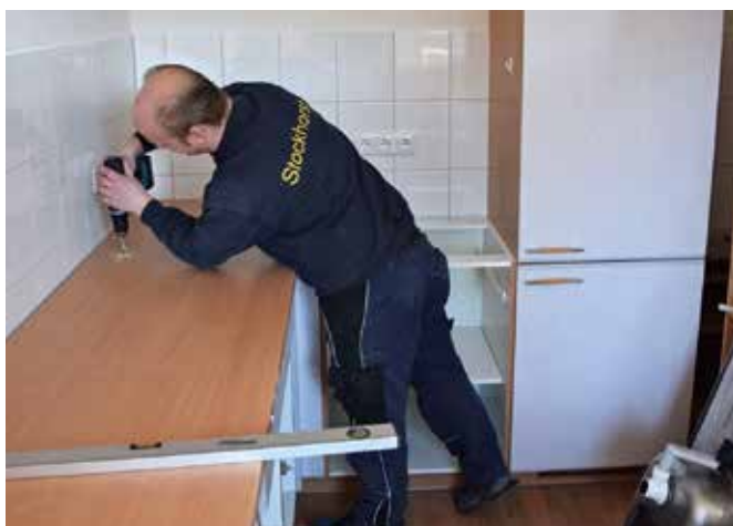
Handwerker beim Aufbau der Küchenmöbel
