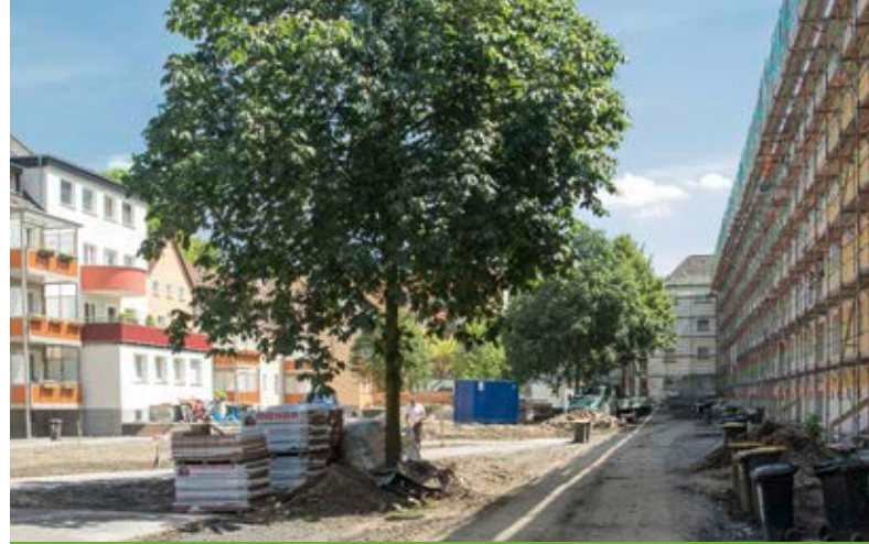
Innenhof, links Rückfronten der Häuser in der Oststraße, die schon fertig sind, rechts die noch nicht fertiggestellten Rückfronten der Nettelbeckstraße
