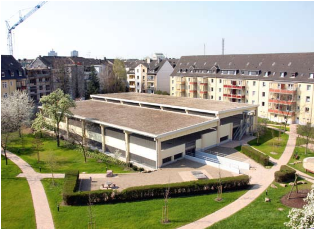
Parkdeck im Innenhof; Blickrichtung Falkstraße
