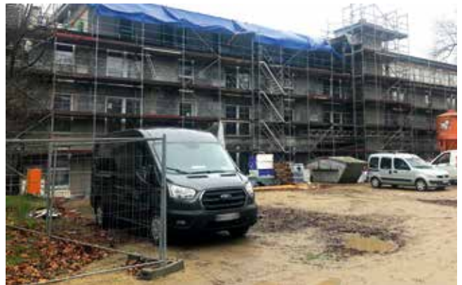
Baustelle Neubau Habichtstraße (Stand: Dezember 2022)
