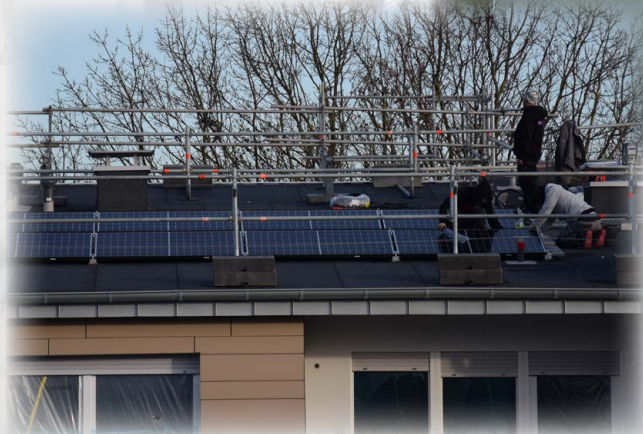
Duisburg-Buchholz Innsbrucker Allee 32 – 40 Photovoltaikanlagen
